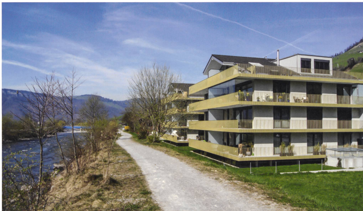
Haus auf Stelzen in Büren/Oberdorf NW: Der bauliche Objektschutz an dieser Immobilie an der Engelberger Aa stellt sicher, dass das Hochwasser nicht ins Gebäude eindringt, ungehindert abfliessen kann und nicht auf die Nachbarparzellen seitlich abgeleitet wird. Architektur: Kontur Architekten, Stans.
