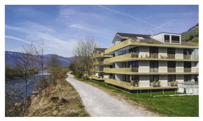
Haus auf Stelzen in Büren/Oberdorf NW: Der bauliche Objektschutz an dieser Immobilie an der Engelberger Aa stellt sicher, dass das Hochwasser nicht ins Gebäude eindringt, ungehindert abfliessen kann und nicht auf die Nachbarparzellen seitlich abgeleitet wird. Architektur: Kontur Architekten, Stans.
