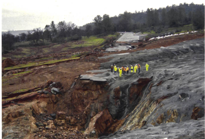
Fels, Gestein und Zementschlamm sollen die von der Erosion geschwächten Hänge unterhalb der Staumauer stärken.
