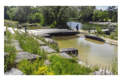
Neu abgedichtet und wieder in den Park eingepasst: **der Reflecting Pool**. Gitter unter der Wasseroberfläche am Übergang helfen mit, Unfälle zu verhüten.
