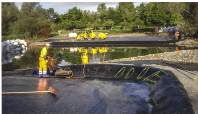
Einbau der Asphaltabdichtung im Uferbereich des Grossweihers.
