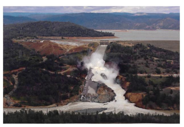
Luftansicht des Lake Oroville, 26. Februar 2017: Oben links ist derjenige Teil des Damms erkennbar, der als Überlauf ausgebildet ist, der Hang darunter ist teilweise stark erodiert. In der Bildmitte die Hochwasser-Notentlastung mit beschädigter Schussrinne.
