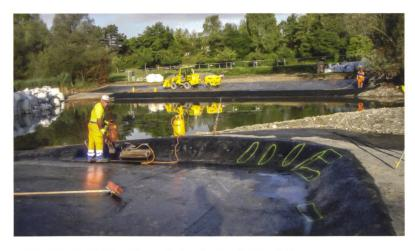
Einbau der Asphaltdichtung im Uferbereich des Grossweihers.
