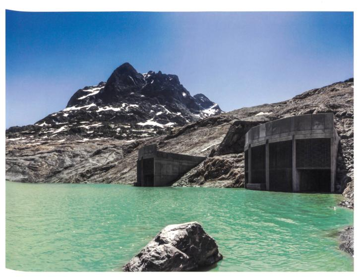
Nant de Drance: Stausee Emosson mit Bogenstaumauer und Ein- und Auslaufbauwerken zum unterirdischen Pumpspeicherkraftwerk.
