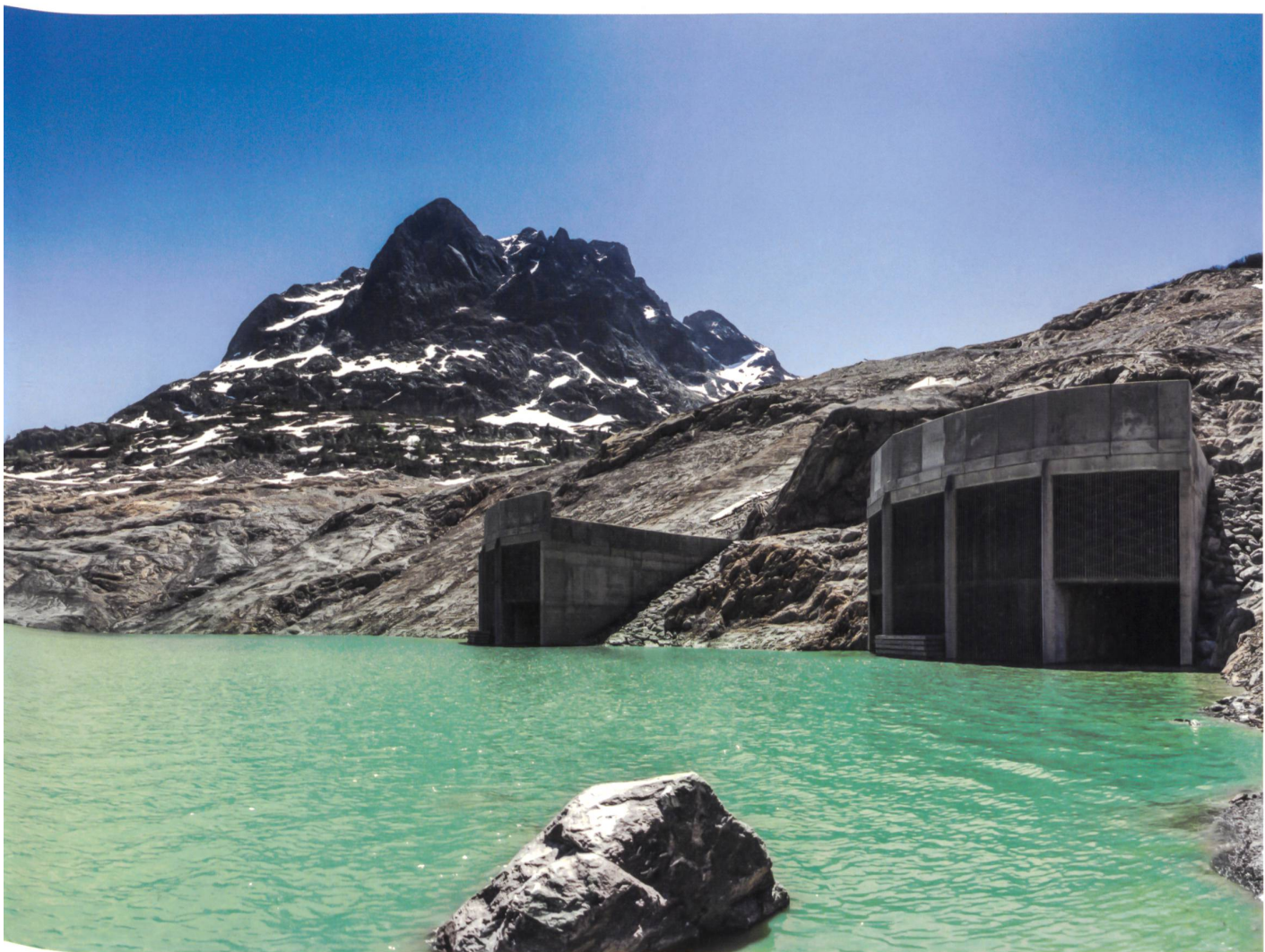
Nant de Drance: Stausee Emosson mit Bogenstaumauer und Ein- und Auslaufbauwerken zum unterirdischen Pumpspeicherkraftwerk.
