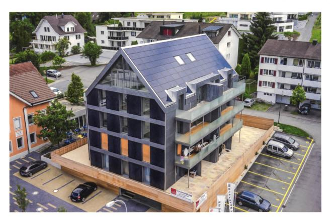
Die West- und Südseite des Mehrfamilienhauses Chrüzmatte in Aesch LU von Mark Röösli, 2016. Es deckt **mit dach- und auf der Westseite fassadenintegrierten PV-Anlagen rund 50% des Gesamtenergiebedarfs**. Drei Batteriespeicher mit einer Kapazität von insgesamt 41 kWh speichern den Energieüberschuss für den Verbrauch in der Nacht. Die städtebauliche Einordnung und der architektonische Ausdruck – ebenfalls wichtige Aspekte einer baukulturell nachhaltigen Bauweise – werfen allerdings Fragen auf.
