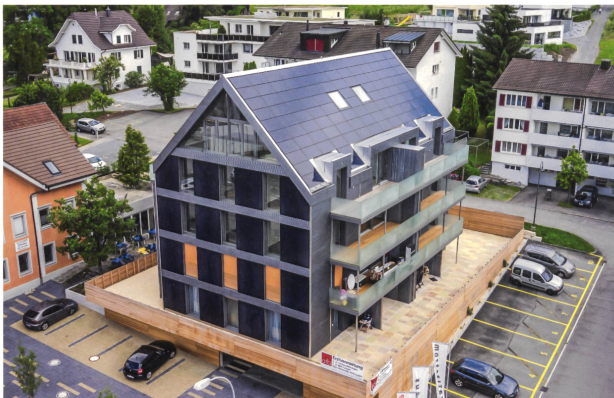
Die West- und Südseite des Mehrfamilienhauses Chrüzmatte in Aesch LU von Mark Rössli, 2016. Es deckt mit dach- und auf der Westseite fassadenintegrierten PV-Anlagen rund 50% des Gesamtenergiebedarfs. Drei Batteriespeicher mit einer Kapazität von insgesamt 41 kWh speichern den Energieüberschuss für den Verbrauch in der Nacht. Die städtebauliche Einordnung und der architektonische Ausdruck – ebenfalls wichtige Aspekte einer baukulturell nachhaltigen Bauweise – werfen allerdings Fragen auf.
