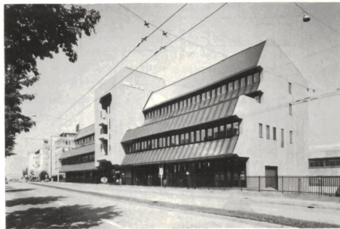
Grundrissanlage vom Südosten. Auf dem westlichen Trakt am Dachgeschoss befinden sich Sonnenkollektoren, auf dem östlichen Teil besteht die Möglichkeit, für den späteren Einbau weiterentwickelter Kollektoren. In den Brüstungen der 1. und 2. Obergeschosse erkennt man die Luftkollektoren
