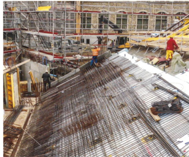
Baustellenfotos während den Ausführungsarbeiten an der Brücke. Die Neigungen der Brückenplatten betragen 45 und 27 Grad. Um sie betonieren zu können, sind Konderschalungen erforderlich. Zuerst betoniert man die Untersicht der Brücke – die nichttragende Aussenhaut –, verlegte die Dämmung und die Bewehrung und betoniert anschliessend die tragende Platte.
