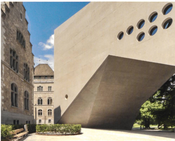
Die charakteristische Brücke aussen ist im Innenraum eine monumentale Kaskadentreppe , über die die Besucher von den Dauer- ausstellungen im Erdgeschoss zu den Wechselausstellungen im zweiten Obergeschoss gelangen. Der Sichtbeton ist etappiert – der Monolith wurde mit etwa 300 Betonieretappen zu einem monolithischen Bauteil erstellt. Durch die Bullaugen gelangt Tageslicht ins Innere, zugleich zeigt sich der Altbau von aussen.
