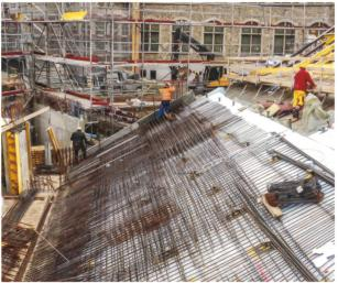
Baustellenfotos während den Ausführungsarbeiten an der Brücke. Die Neigungen der Brückenplatten betragen 45 und 27 Grad. Um sie betonieren zu können, sind Konterschalungen erforderlich. Zuerst betonierte man die Untersicht der Brücke – die nichttragende Aussenhaut –, verlegte die Dämmung und die Bewehrung und betonierte anschliessend die tragende Platte.
