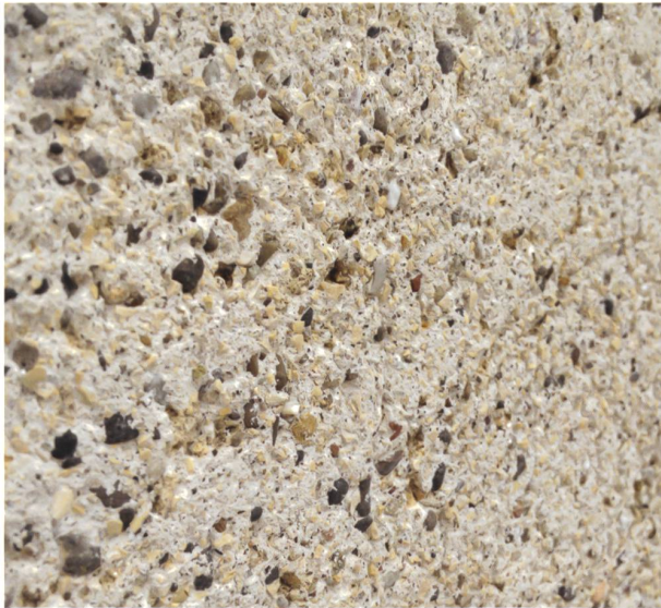
Um die Gesteinskörnung der Sichtbetonfassade stärker sichtbar zu machen, und den Bezug zum Altbau mit seiner Bruchsteinfassade aus Tuff herzustellen, liess man die Fassade unter Hochdruck 5 mm wasserstrahlen.
