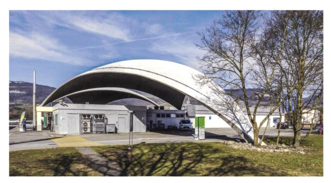
Die Schalen 2017 mit dem dominanten, aber originalen weissen Farbanstrich. Der neu angebrachte Schneefang wird der Anforderung der Betriebssicherheit gerecht; die Ästhetik der Schalen wird dadurch stark beeinträchtigt. Noch störender sind allerdings die Bauten darunter, die der ursprünglichen Funktion der Schalen als Dach widersprechen.
