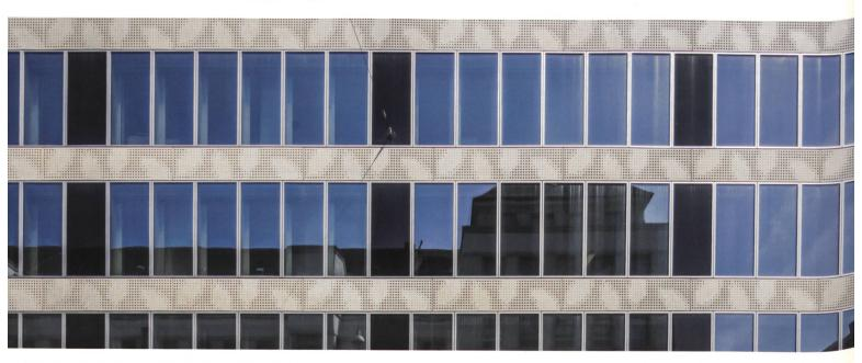
Betonbrüstung individuell: Für die Blätteroptik am Objekt Bleicherweg, Zürich, sorgen Rundungen die verschieden gross und tief sind. Weitere Ideen und Umsetzungen: betonelementwerk.ch
