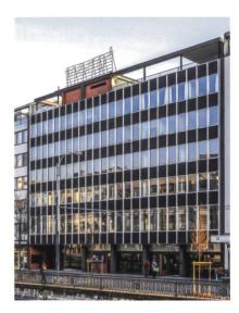
Die Strassenfassade nach der Instandsetzung: Profile, Aussenplatten und Fenster wurden für einen neuen Lebenszyklus gereinigt, gestrichen und repariert.
