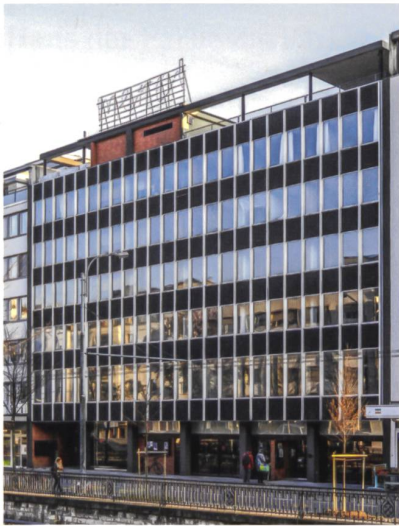
Die Strassenfassade nach der Instandsetzung: Profile, Aussenplatten und Fenster wurden für einen neuen Lebenszyklus gereinigt, gestrichen und repariert.
