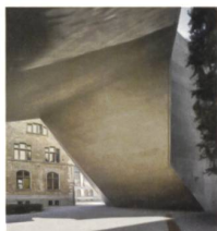
Der «Torbogen» im Neubau des Landesmuseums Zürich dient als Durchgang vom Hof in den Park. Zugleich fungiert er im Innern als Brücke mit monumentaler Kaskadentreppe. Statistisch funktioniert die Brücke als Dreibein. Coverfoto von Keystone/Christian Beutler.
