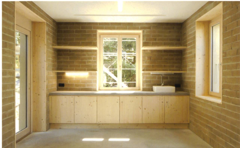
Die Küche des Jardin Botanique-Alpin in Meyrin GE von Véronique Favre Architectes ist mit Lehmbausteinen von terrabloc gemauert.
