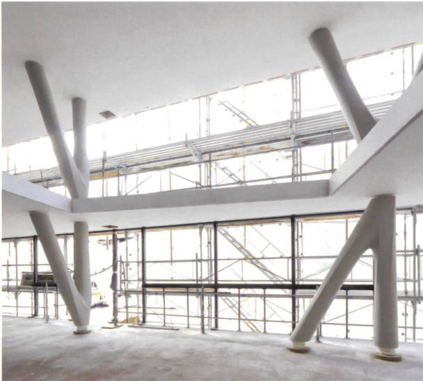
Die rechte Stütze im unteren Geschoss ist die auf den Kopf gestellte Variante der linken. Die Stütze darüber wurde mit einer zweiten Schalung erstellt.
