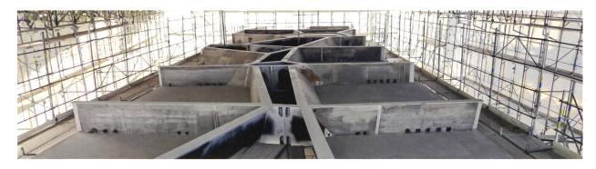
Die **komplexe Voronoi-Stahlstruktur aus lasergeschnittenen Blechen** wurde in Teilen im Werk vormontiert. Der Brandschutz wird durch Ausfachungen aus Beton sowie Verkleidungen mit Brandschutzplatten sichergestellt.
