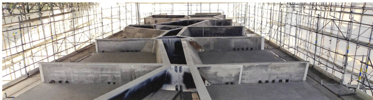
Die komplexe Voronoi-Stahlstruktur aus lasergeschnittenen Blechen wurde in Teilen im Werk vormontiert. Der Brandschutz wird durch Ausfachungen aus Beton sowie Verkleidungen mit Brandschutzplatten sichergestellt.
