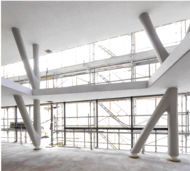
Die rechte Stütze im unteren Geschoss ist die auf den Kopf gestellte Variante der linken. Die Stütze darüber wurde mit einer zweiten Schalung erstellt.
