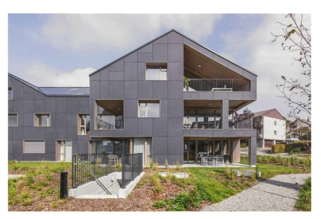
Elektrische Energie wird von PV-Modulen sowohl an der Fassade (amorph) als auch auf dem Dach (kristallin) bereitgestellt.
