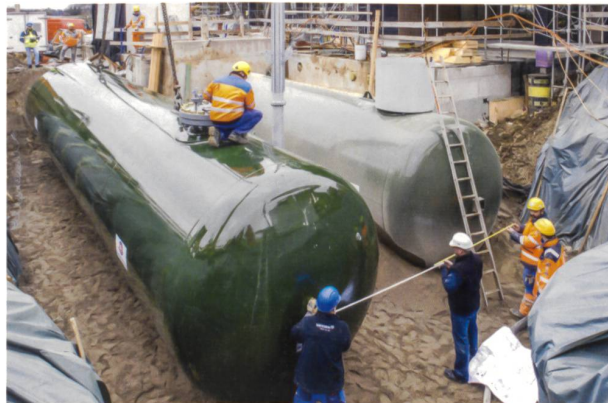
Wasserstofftanks zur Langzeitspeicherung von elektrischer Energie. Bei der Elektrolyse entstehen Strom, Wärme und Wasser.
