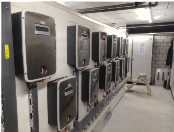
Die Wechselrichter stehen in der Energieversorgung des Mehrfamilienhauses zwischen Produktion und Verbrauch.
