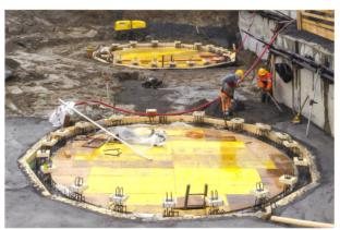
Zur **Speicherung von thermischer Energie** dienen zwei unterirdische Wassertanks mit einem Durchmesser von je 6 m.
