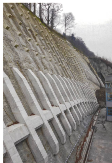
Abgeschlossene Sanierung, Blickrichtung West.
