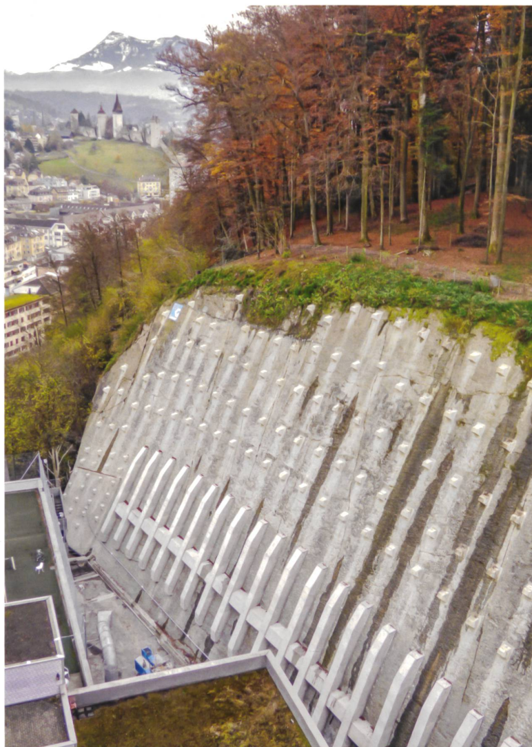
Östlicher Teil der Felssicherung im ehemaligen Steinbruch Sagenmatt, dem grössten von ehemals 20 auf Luzerner Stadtgebiet. Die Museggmauer im Hintergrund und weitere Bauten Luzerns bestehen aus derartigem Plattensandstein. Die Rigi (ganz hinten) allerdings nicht. Sie baut sich vorwiegend aus Nagelfluh auf.
