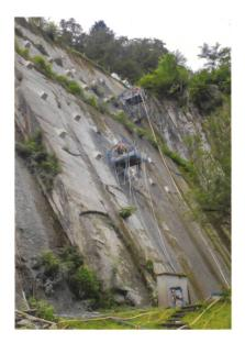
Hängende Bohrschlitten zur Erstellung der Einzelanker.
