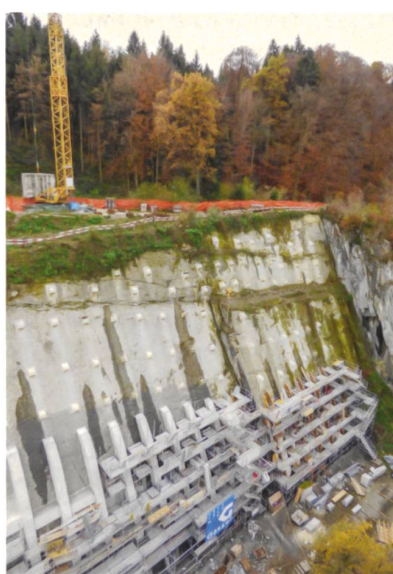
Gerüste zur Erstellung der Rippen und Longarinen.
