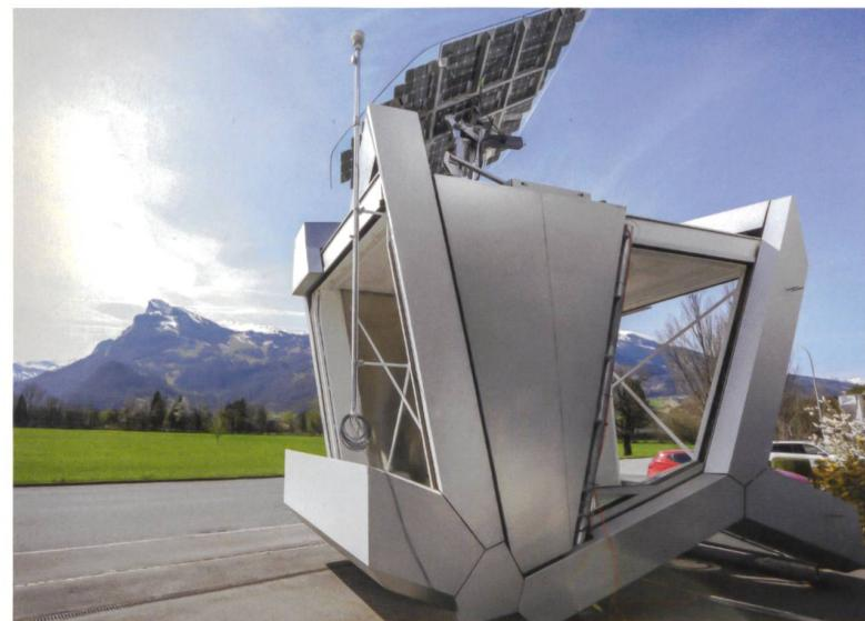
Die beweglichen Bauteile, die das Mehrfamilienhaus in Vaduz (FL) mit Wärme, Kälte und Strom versorgen, wurden mehrere Jahre lang im Realversuch getestet.
