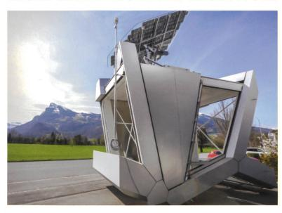
Die beweglichen Bauteile, die das Mehrfamilienhaus in Vaduz (FL) mit Wärme, Kälte und Strom versorgen, wurden mehrere Jahre lang im Realversuch getestet.
