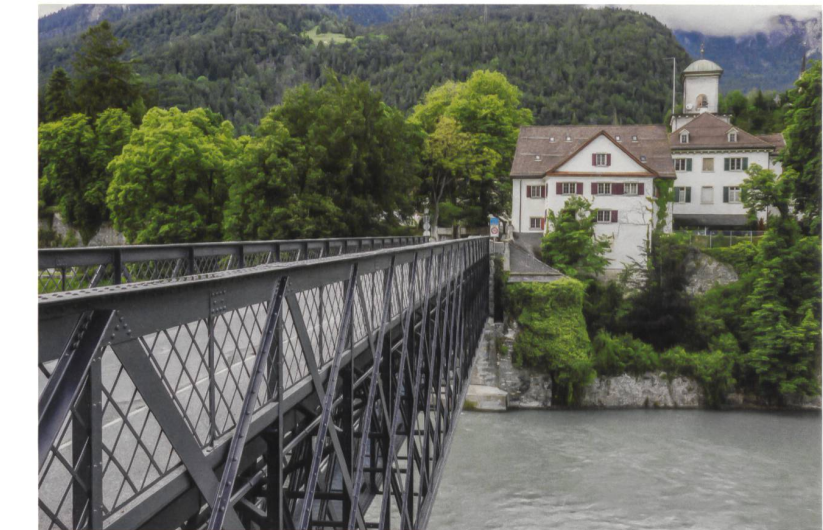
Baukultur meint auch den Erhalt historischer Ingenieurbauwerke – wie etwa der 135 Jahre alten Eisenfachwerkbrücke über den Rhein bei Reichenau GR . Sensibel erneuert wurde die Brücke 2014/15 vom Ingenieurbüro Conzett Bronzini Partner aus Chur.
