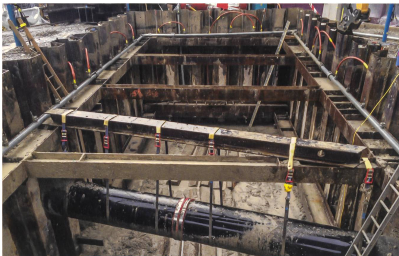
Links: Durchdringung der Spundwand mit der Abwasserleitung vor dem Bau des Ölrückhaltebeckens. Blickrichtung West. Rechts: Das unterirdische Ölrückhaltebecken wird um die Abwasserleitung herumgebaut. Blickrichtung Ost.
