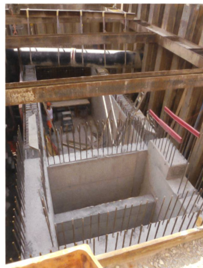
Links: Durchdringung der Spundwand mit der Abwasserleitung vor dem Bau des Ölrückhaltebeckens. Blickrichtung West. Rechts: Das unterirdische Ölrückhaltebecken wird um die Abwasserleitung herumgebaut. Blickrichtung Ost.
