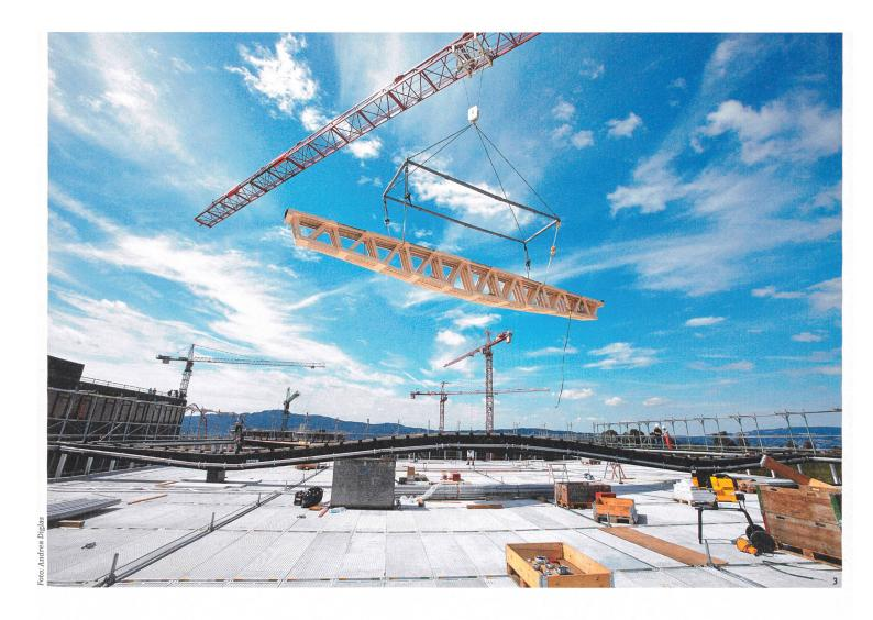
Beim Projekt des «sequenziellen Dachs» steht das Zusammenspiel von computergestützter Konstruktion und Roboterfabrikation ebenso im Mittelpunkt der endgültigen Architektur wie auch der Fertigungsprozess. Dadurch wird das traditionelle Spektrum des Holzbaus beträchtlich erweitert und das Gebiet der Roboterfabrikation auf einen neuen Massstab gebracht.<sup>4</sup>
