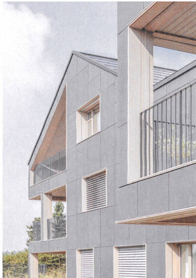
Ein zweiter Preis ging an ein energieautarkes Mehrfamilienhaus an der Unterdorfstrasse in Brütten ZH.
