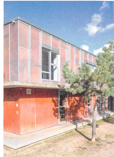
Ebenfalls mit dem zweiten Preis ausgezeichnet wurde die Kinderkrippe Châteaubriand in Genf .
