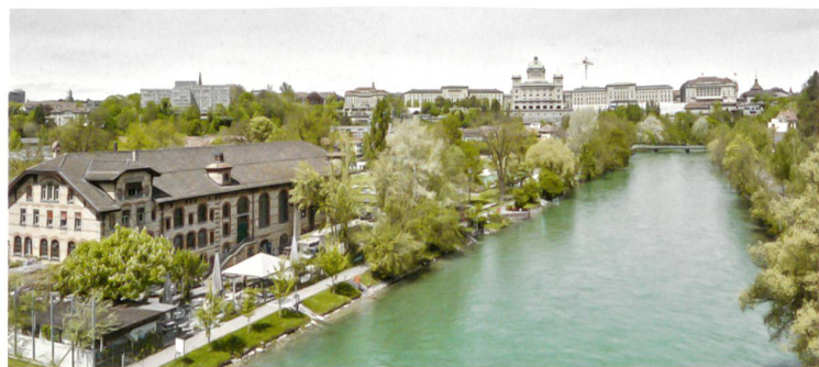
Der Betrachtungsumfang umfasste die südliche Stadtansicht. Das Bearbeitungsobjekt ist das Bürogebäude links oben.
