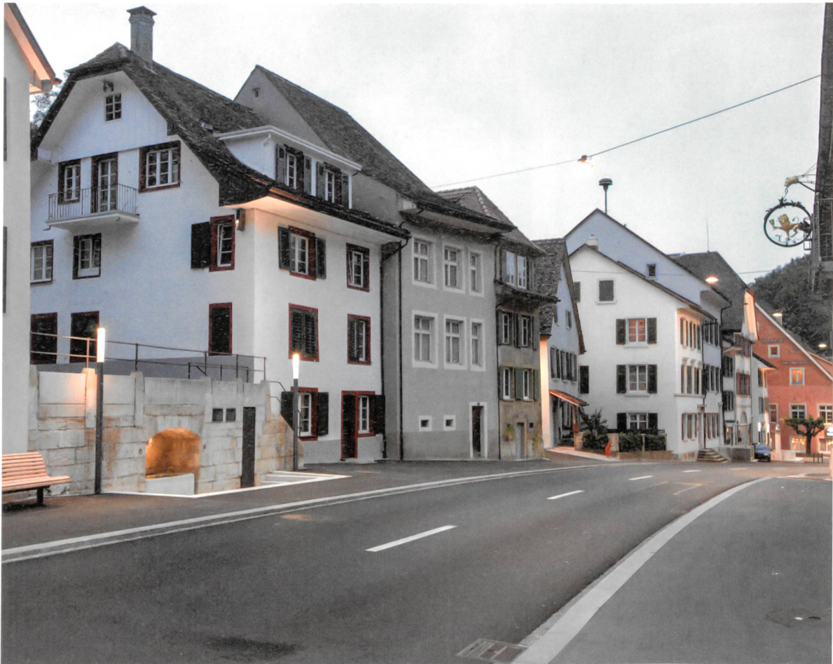
Mit dem Projekt «Ortsdurchfahrt Waldenburg» siegte art light aus St. Gallen in der Kategorie Aussenbeleuchtung/Öffentliche Bereiche.
