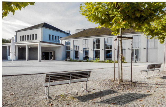
Die sorgfältige Innen- und Aussensanierung der Kurbrunnenanlage sichert die wertvolle Bausubstanz und schafft Öffentlichkeit.
