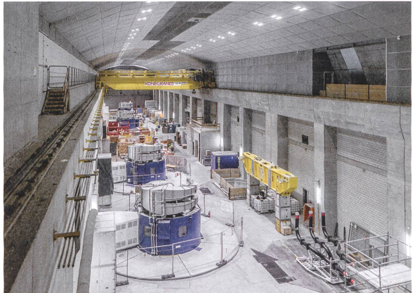
Rentabler Beitrag zur Energiewende? Maschinenkaverne des neuen Pumpspeichers Limmern mit den vier Maschinengruppen. Umwandlung von Grund- in Spitzenlaststrom – egal aus welcher Quelle.
