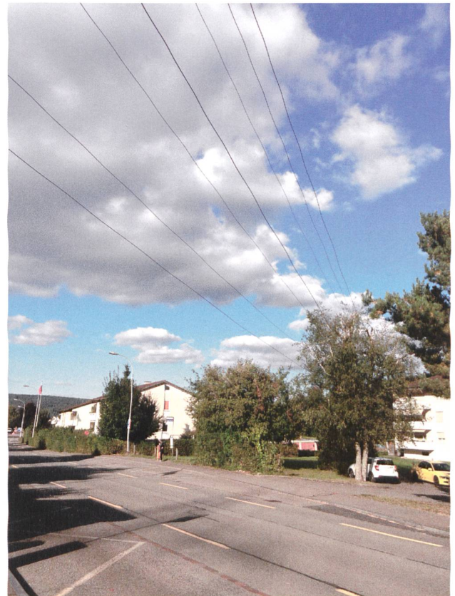
220-kV-Freileitung über dem Siedlungsgebiet in Riniken; die bestehende Trasse wird grossräumig verlegt und auf einem kurzen Abschnitt in den Boden gelegt. In niedrigeren Spannungsbereichen ist die Erdverkabelung bereits mehrfach ausgeführt worden.
