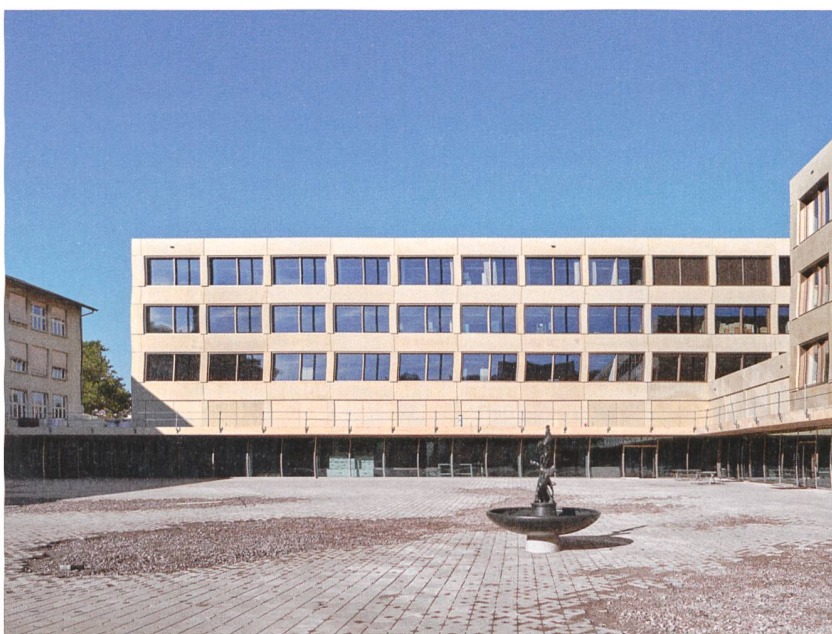
Schulhaus Sandgruben , Altbau (links) und Neubau vom Pausenplatz aus. Der Altbau wird bis Sommer 2017 von Stücheli Architekten instandgesetzt.
