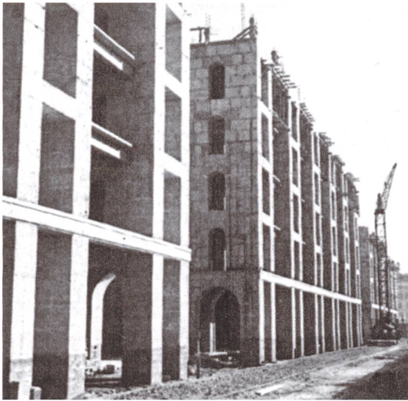
Baustelle der Wiederaufbauarbeiten: Deutlich zu erkennen ist die vorgelagerte Raumschicht mit Loggien und erdgeschossigen Arkaden. Dahinter wird der selbsttragend vermauerte Kalkstein mit bewehrtem Beton hinterfüllt.
