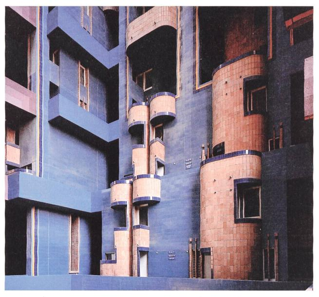
Walden 7: Bald nach der Fertigstellung begann die Utopie zu bröckeln, Bauschäden traten auf. **Später wurde die ursprüngliche Fliesenfassade zu grossen Teilen durch Putz ersetzt**. Das Bild aus den 1970er-Jahren zeigt einen Hof im Originalzustand mit Kacheln.
