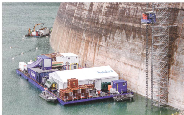
Ponton mit den Einrichtungen für die Unterwasserarbeiten.
