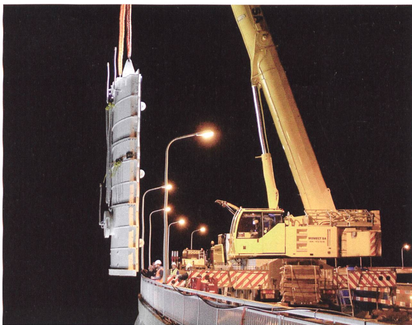
Der Abschluss für den Grundablass wird für die spätere Montage an der Staumauer vor dem Einlauf positioniert.
