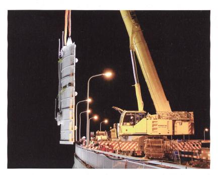
Der Abschluss für den Grundablass wird für die spätere Montage an der Staumauer vor dem Einlauf positioniert.
