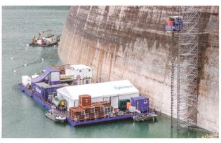
Ponton mit den Einrichtungen für die Unterwasserarbeiten.
