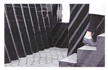
$Durch\ den\ Einsatz\ von\ 3-D-Druck\ sind\ \textbf{Boden},\ \textbf{Wand}\ und\ \textbf{Treppe} \\ \textbf{im}\ \textbf{Amsterdamer}\ \textbf{Kanalhaus}\ nicht\ nur\ sprichwörtlich\ aus\ einem\ Guss.$
