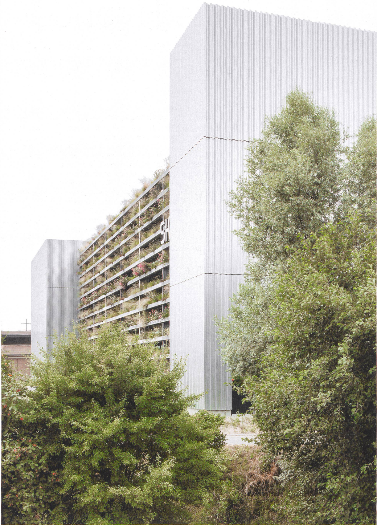
Vom Industriebau zum Hybrid: Hinter der bepflanzten Fassade des Sky-Frame-Gebäudes sind Werkstatt und Verwaltung vereint.
