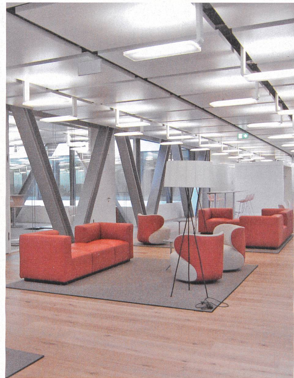
Das Tragwerk der Verbindungsgänge ist als Brücke ablesbar und das zentrale Element des Gebäudes: Es gliedert das Volumen, vermittelt zwischen Bürotrakt und Versuchshalle und stellt den räumlichen Bezug her.
