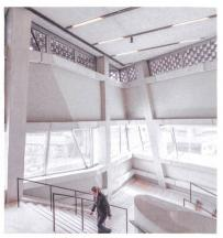
Links: Die Betontragelemente der Erweiterung, hier die schrägen Stützen, verflechten sich optisch und statisch mit der bestehenden Tragkonstruktion des erhaltenen Sockels. Die neue Tragkonstruktion wächst regelrecht aus der alten Unterkonstruktion heraus. Rechts: Der Skelettbau aus Beton als markante Tragstruktur der Erweiterung prägt den Innenraum. Die Öffnungen zwischen den Tragelementen lassen sich frei bespielen; Konsolen, die wie Arme aus den Stützen ragen, tragen die Ausfachungen.
