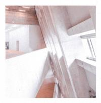
Aussparungen in den Decken entlang der Fassaden verbinden die Geschosse optisch miteinander und lassen die vertikalen Tragelemente frei: Sie zeigen sich in ihrer vollen Grösse und werden im Innenraum durchgehend erlebbar.
