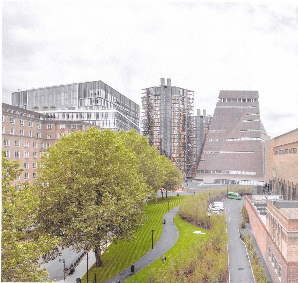
Der pyramidenartige Turm des Neubaus auf der Südseite der Bankside Power Station lehnt sich in der Materialität dem Bestand an. Gleichzeitig emanzipiert er sich damit von den nahe gelegenen Büro- und Apartmenthäusern. Die expressive Form ergab sich unter anderem aus Rahmenbedingungen wie Sichtachsen oder dem Vermeiden von Beschattungen.
