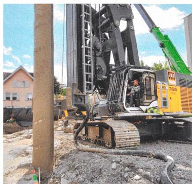
In Zug erstellte die JMS Risi eine Baugrube innerhalb einer wasserdichten Baugrubenumschliessung, da die Grube mit bis zu zwei Untergeschossen im Grundwasser lag. Schlitz- und Spundwände zur Sicherung liessen sich aufgrund der Platzverhältnisse und zu befürchtender Lärm- und Erschütterungsemisionen nicht realisieren. Man setzte daher auf eine überschnittene Bohrpfahlwand mit Pfahldurchmesser 770 mm, die mit dem neuen Bohrgerät Liebherr LRB355 im Doppelkopfbohrverfahren erstellt wurde. •
