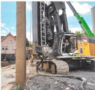
In Zug erstellte die JMS Risi eine Baugrube innerhalb einer wasserdichten Baugrubenumschliessung, da die Grube mit bis zu zwei Untergeschossen im Grundwasser lag. Schlitz- und Spundwände zur Sicherung liessen sich aufgrund der Platzverhältnisse und zu befürchtender Lärm- und Erschütterungsemissionen nicht realisieren. Man setzte daher auf eine überschnittene Bohrpfahlwand mit Pfahldurchmesser
