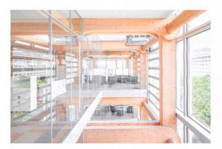
Beim Tamedia-Verlagshaus in Zürich (Baujahr 2013, vgl. TEC21 46/2013) sorgen flexible Grundrisse sowie die Trennung von Konstruktion, Technik und Ausbau für räumliche Nutzungsflexibilität. Die Holzverbindungen sind fast gänzlich ohne Metallteile ausgeführt, die Leuchten gut erreichbar in die Zwischenräume der Holzträger eingefügt.
