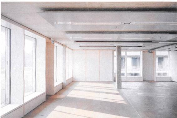
Der Bürobau des IUCN in Gland (Baujahr 2010) **trennt Tragstruktur, Hülle und Gebäudetechnik systematisch**. Das Gebäude hat Sichtbetonoberflächen und verzichtet auf Verputze und Verkleidungen. Die Gebäudetechnik ist auf ein Minimum reduziert, Beleuchtung, Heizung, Kühlung und Abluft sind in abgehängten Paneelen untergebracht.
