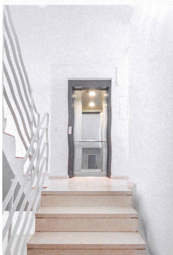
Fotos: Schindler Aufzüge
