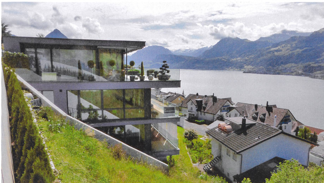
Die Schutzmauer im Vordergrund schützt den Neubau in Ennetbürgen NW vor den Fluten nach einem Starkregen.
