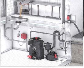
Mit maximal 80 cm Breite ecken TECEsepa Fettabscheider nirgendwo an und machen auch beim Einbau immer eine
