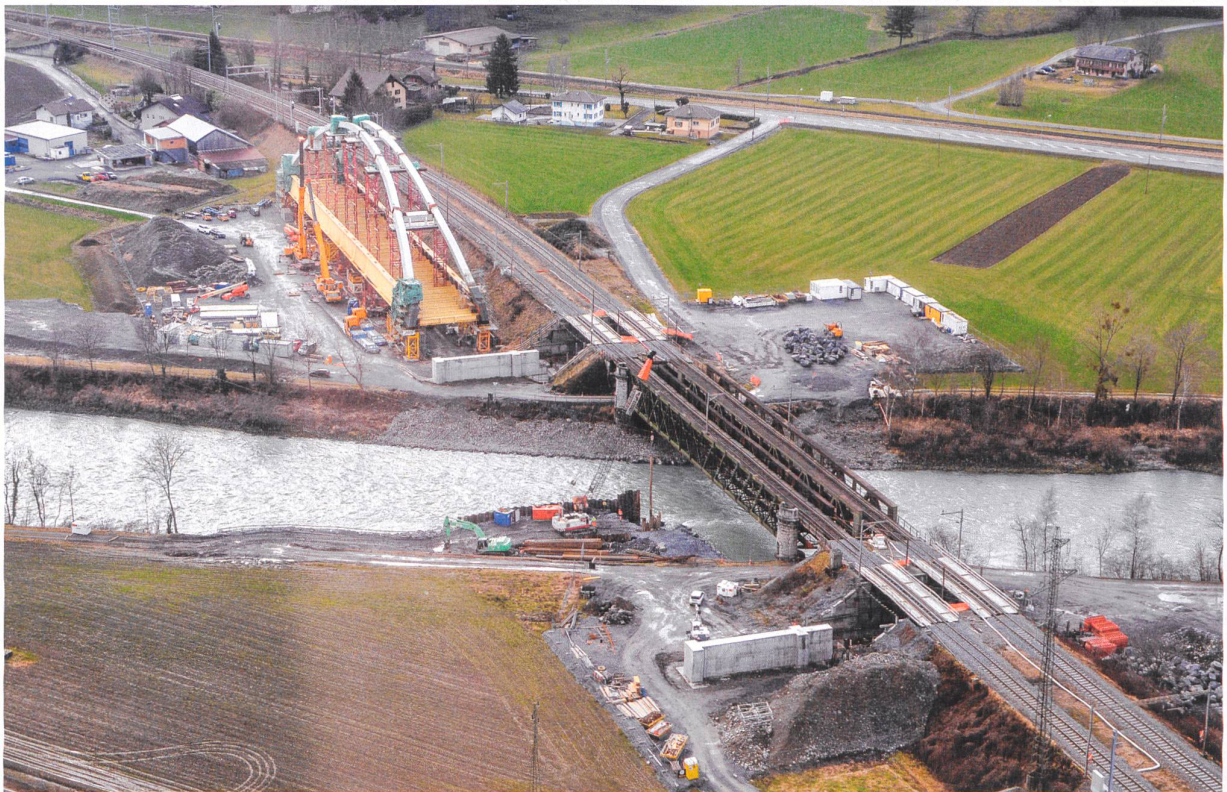
Stahlkonstruktion der neuen Brücke auf dem Installationsplatz mit den beiden Vorschublagern beidseits der Rhone und der Plattform für die provisorischen Pfeiler am rechten Ufer. Die beiden definitiven Widerlager entstehen in den Baugruben im Eisenbahndamm unter den vier Behelfsbrücken (Fliessrichtung von links nach rechts).
