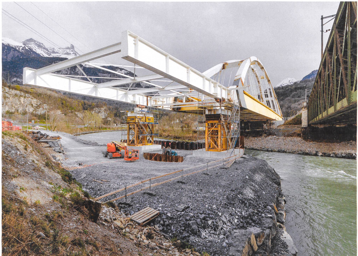
Der 30 m lange Vorbauschnabel hat die provisorischen Pfeiler am rechten Rhoneufer (Fließrichtung von links) erreicht. Nach dem weiteren Vorschub über den Fluss wird die Brücke stromabwärts gegen die bestehende Fachwerkkonstruktion verschoben.
