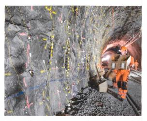
Vor der Sprengung: 1492 Sprenglöcher, verteilt auf 76 m Länge, eine Detonation ergeben nach 3.3 Sekunden  $\dots$
