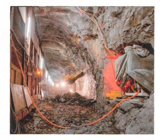
Querschnittsvergrösserung durch Gesteinabtrag mittels Felsbrecher an Kalotte und Strosse am talseitigen Gleis im Bereich Saint-Maurice (Blickrichtung nach Bex); links die Schutzwand.
