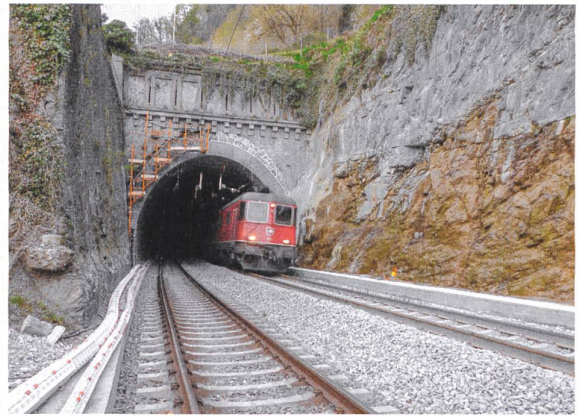
Nördliches Tunnelportal auf Bexer Seite nach Fertigstellung mit den darüber liegenden Schiesscharten der Befestigungsanlage Dufour .
