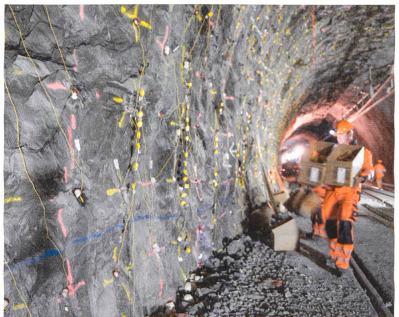
Vor der Sprengung: 1492 Sprenglöcher, verteilt auf 76 m Länge, eine Detonation ergeben nach 3.3 Sekunden ...
