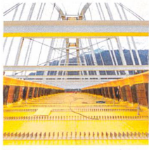
Die Stahlkonstruktion der neuen Eisenbahnbrücke Massongex vor dem Betonieren des Fahrbahntrogs. Coverfoto von Hartmut Mühlberg.
