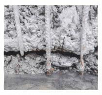
Hauptbewehrung eines Stützbauwerks mit erheblichem Korrosionsgrad und Querschnittsverlust.
