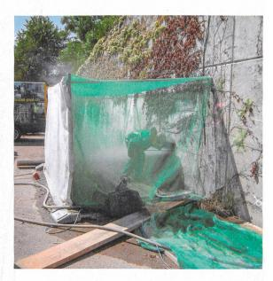
Beispiel einer Untersuchung an bestehenden Winkelstützmauern: talseitiger Höchstdruckwasserabtrag mit vorgängigem Aushub.
