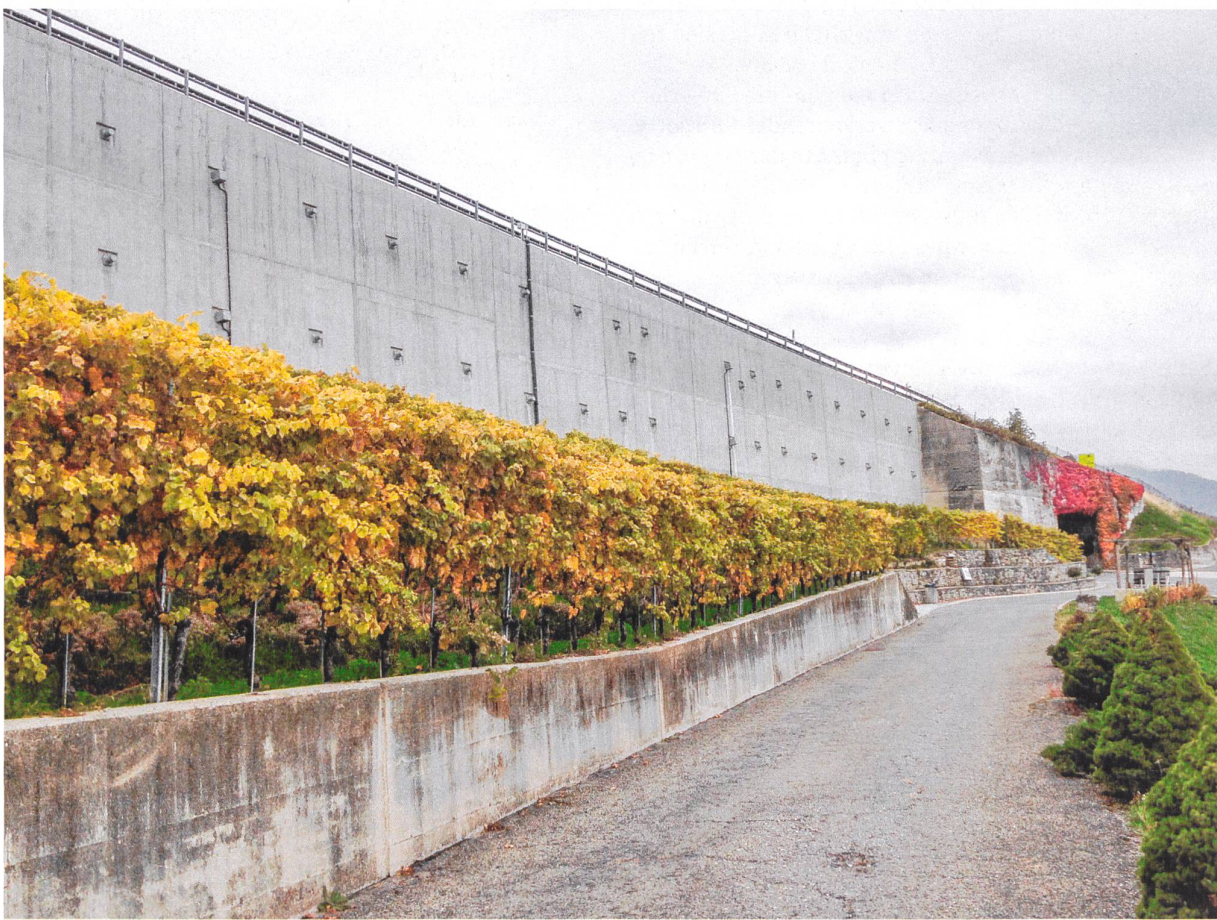
Verstärkung der talseitigen Stützmauer der Autobahn A9 bei Chexbres VD.
