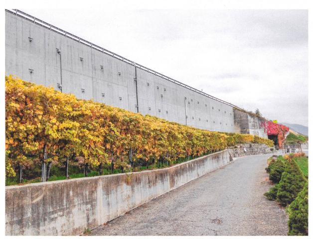
Verstärkung der talseitigen Stützmauer der Autobahn A9 bei Chexbres VD.
