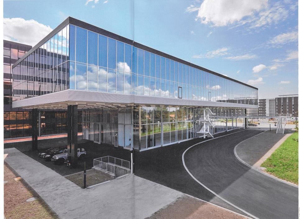
1 Ressourcenschonend: Das Arch\_Tec\_Lab wurde auf dem Dach einer bestehenden Tiefgarage errichtet. So konnte nicht nur der Landverbrauch minimiert, sondern auch Material gespart werden. | Saving resources: the Arch\_ Tec\_Lab was built on the roof of an existing underground car park, minimising land use and saving on materials.
