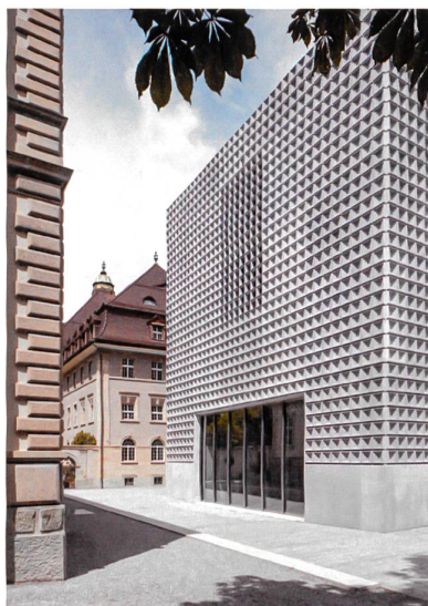
Die charakteristischen Betonelemente der Fassade verbergen strategisch platzierte Öffnungen: hier einmal in der Westfassade, im Detail und von innen nach aussen (von links nach rechts).
