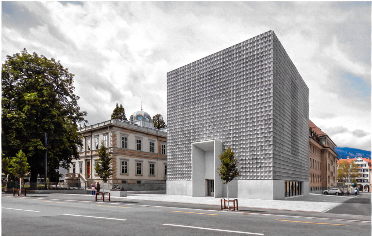
Das klar gefasste abstrakte Volumen ist gekennzeichnet von der Struktur der vorgefertigten Betonelemente. Die Entwerfer berufen sich auf die Ornamente der Villa Planta – das Resultat hingegen spricht eine eigenständige Sprache.
