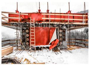
Links: Armierung eines Bogensegments. Rechts: Anschlussbewehrung und Spanngliedverankerungen am Ende einer Überbauetappe.
