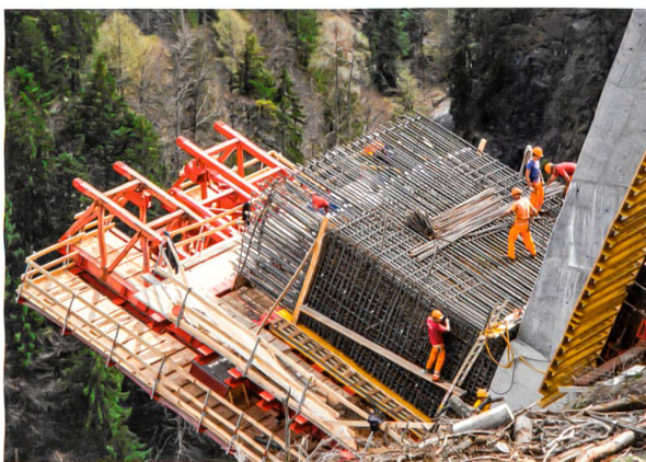
Links: Armierung eines Bogensegments. Rechts: Anschlussbewehrung und Spanngliedverankerungen am Ende einer Überbautetappe.
