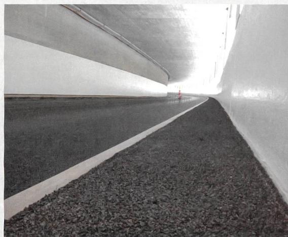
Jordiguhittinogalerie mit Innenbeschichtung Emcephob HPC in RAL 9010
