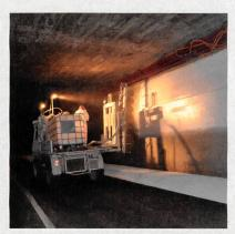
Automatisierte Beschichtungsarbeiten in der Schallbettgalerie durch die Fa. Trauffer AG, Brienz
