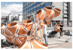
Die Teilnehmenden des itech-Masterprogramms montieren die von ihnen entwickelten Dachsegmente vor Ort.
