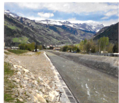
Der seitliche Geschiebesammler am Schächchen mit einem Volumen von 100 000 m 3 .
