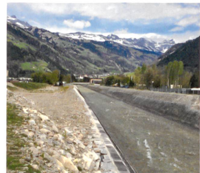
Der seitliche Geschiebesammler am Schächen mit einem Volumen von 100 000 m 3 .
