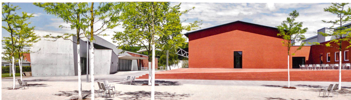
Der Vorplatz und das räumliche Verhältnis zum Feuerwehrhaus von Zaha Hadid.
