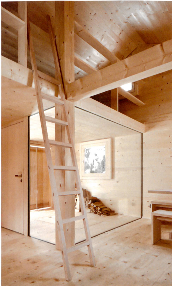
Die 12 cm dicken Tannenh Holz wände sind nicht isoliert. Im zweistöckigen Teil verbindet über dem isolierverglasten Eingangsbereich eine Galerie die Etagen.
