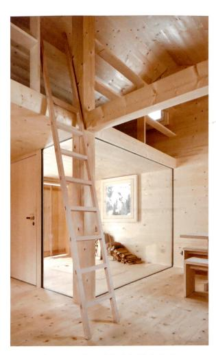
Die **12 cm dicken Tannenholzwände** sind nicht isoliert. Im zweistöckigen Teil verbindet über dem isolierverglasten Eingangsbereich eine Galerie die Etagen.
