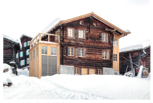
Bei den Anbauten dominierten das **wetterbeständige Lärchenholz und die eingebauten Sonnenkollektoren**. Sägerohe Bretter sind in ihrer maximalen Breite stumpf gestossen und deren Fugen mit einer Deckenleiste geschlossen.
